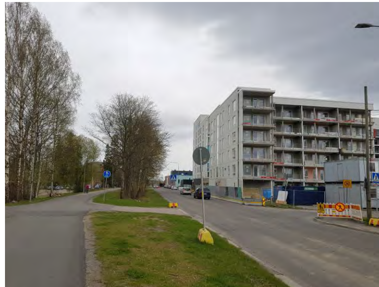
Teivaalantien ja teivaankujan liittymä 10.5.2020
